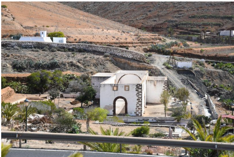
Ruinas del convento y paredes de la iglesia conventual
